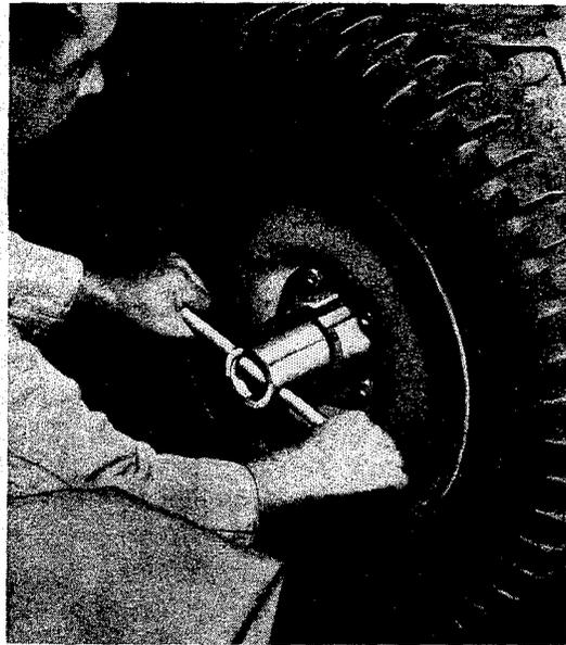
Fig. 194 Schlüssel für Radlagermutter
